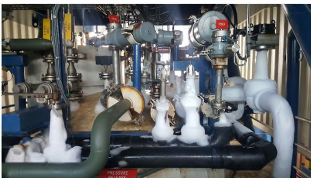
Рисунок 5 - Домна танка с клапанами и сенсорами контроля СПГ
